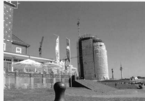
Ein Teil der „Havenwelten“ – Die Baustelle des Atlantik Hotel Sail City. Fotos: Lindemann/Rauprich
